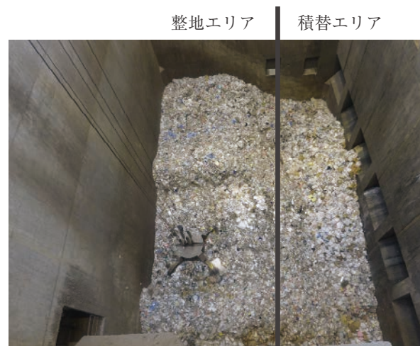
図2 ごみピット内
